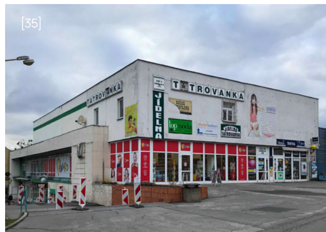
✗ Velké množství reklamních prvků přehlčuje prostor. Budova se pod nánosem ztrácí. Celé to podtrhuje nevalná kvalita nosičů a jejich neutržovanost.
